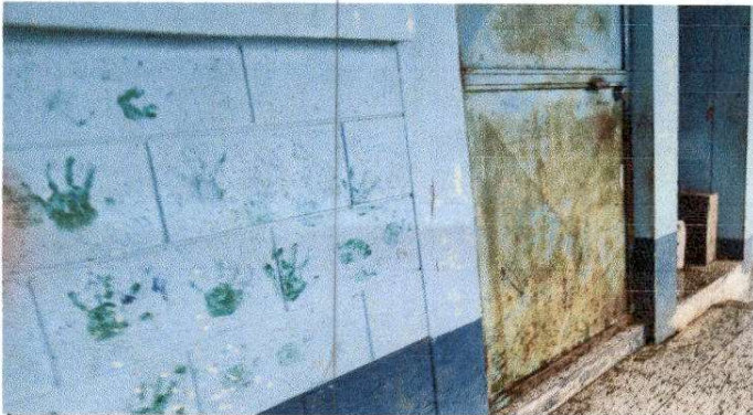
Foto 4: Chapas deterioradas
